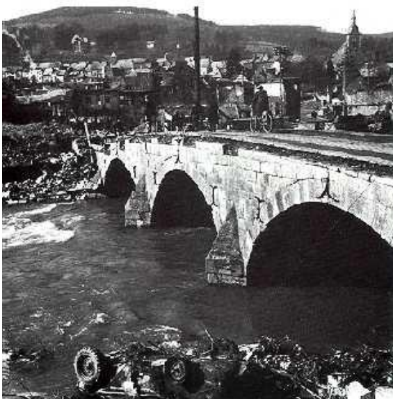
The Ambleve River bridge
